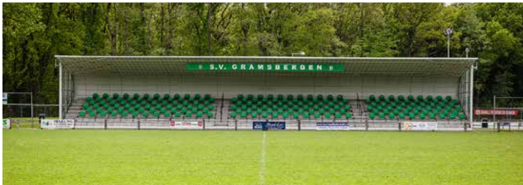
Vasemmalla SV Gramsbergenin uudelleenrakennettu katsomo on valmis uuteen kuumasinkityn teräksen käyttökertaan. Rakenteen kokonaisainajaksi voi tulla yhteensä 100 vuotta
